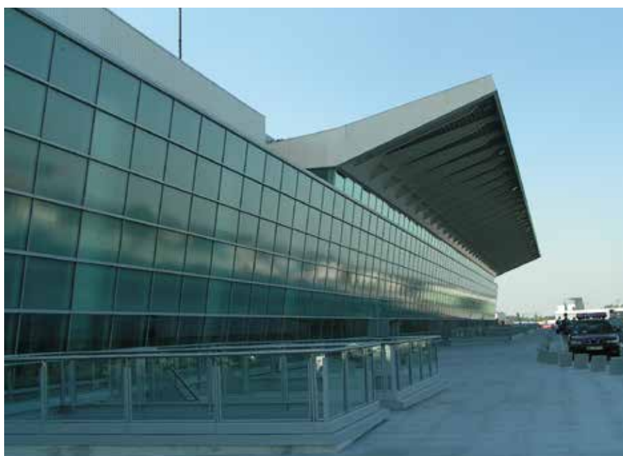
Letiště Fryderyka Chopina , Varšava, Polsko projekt / arch. Pierluca Roccheggiani, arch. Paweł Czaplicki
